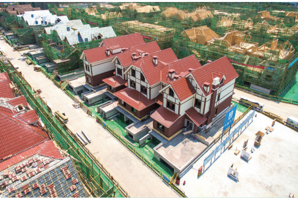
中加生态示范区—班芙小镇·枫丹园轻型木结构 Super E° 联排住宅
